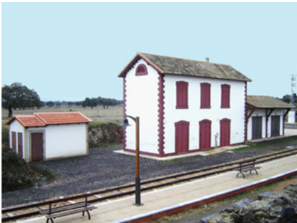
Estación de ferrocarril restaurada del Cerco (Villanueva del Duque)
