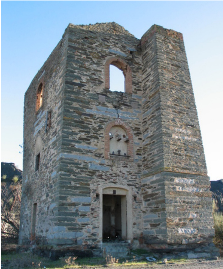
Casa de Máquinas de Mina Terreras
